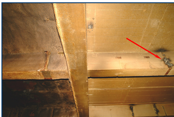
Fig. 3-38 Vue de la zone de travail. La flèche indique les traces du travail au chalumeau sur la poutrelle métallique
