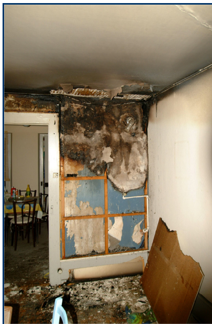
Fig. 3-26 Vue de l'emplacement du chauffage à gaz et des dégâts
