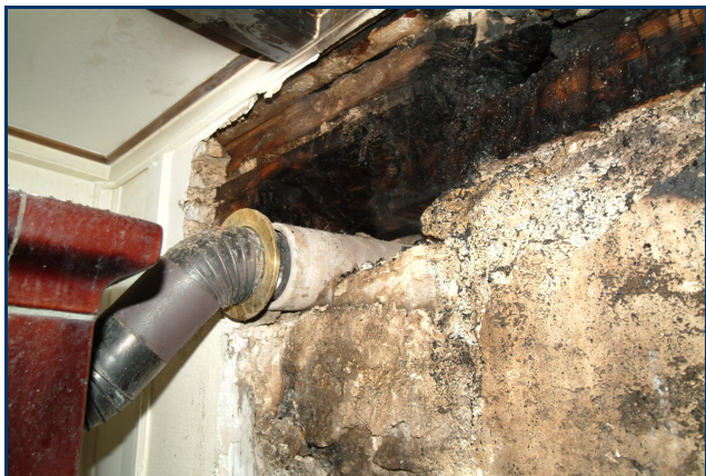
Fig. 2-19 Partie arrière du fourneau à catelles avec son tuyau de raccordement.
