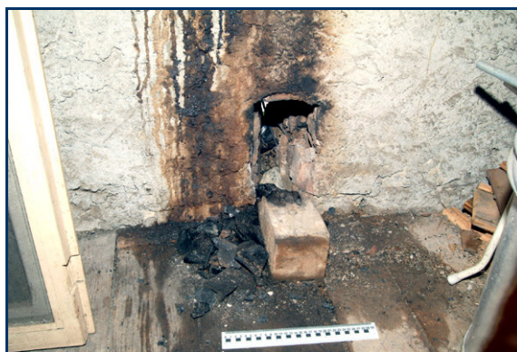
Fig. 4-29 Reste de la poutre calcinée qui passait à proximité immédiate du conduit de cheminée.
