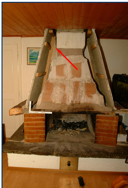
Fig. 3-8 Hotte partiellement démontée par les pompiers
