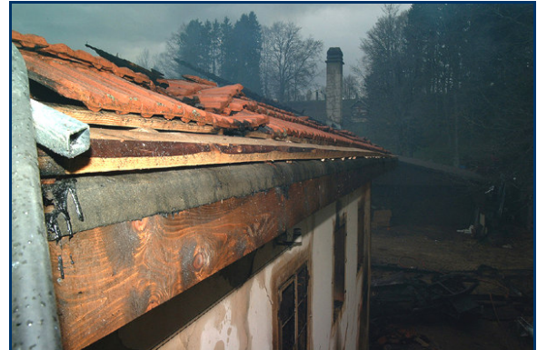
Fig. 4-36 Portion de la toiture illustrant la pose de papier goudronné sur l'avant-toit.
