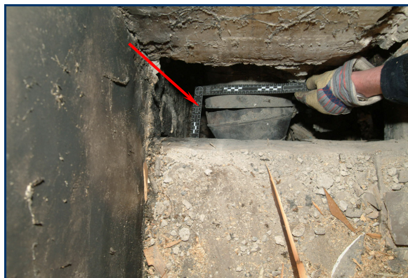
Fig. 3-7 Autre interstice visible lors du raccordement non soudé à la cheminée
