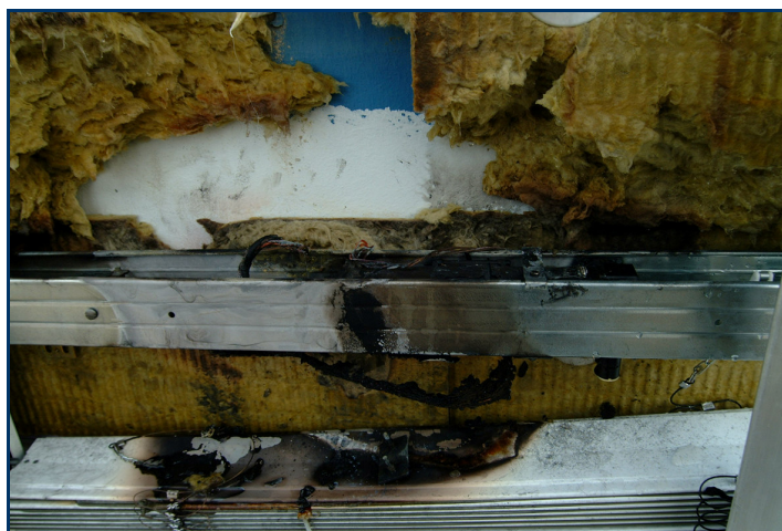
Fig. 3-67 Vue de détail de la partie située immédiatement à l'arrière de l'installation motorisée du store à lamelles
