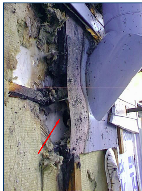
Fig. 2-22 Détail du conduit d'évacuation des gaz à proximité immédiate du lattage en bois
