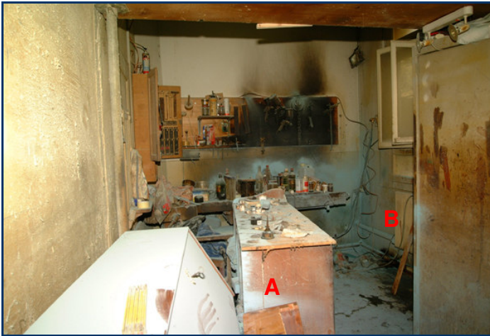
Fig. 3-60 Vue générale de l'atelier d'ébénisterie, avec A : emplacement de travail, B : origine de l'incendie
