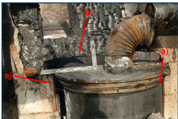
Fig. 2-15 Détail de l'installation de chauffage : a) pourtour fibrociment - bois - brique ; b) surface supérieure : bois - brique
