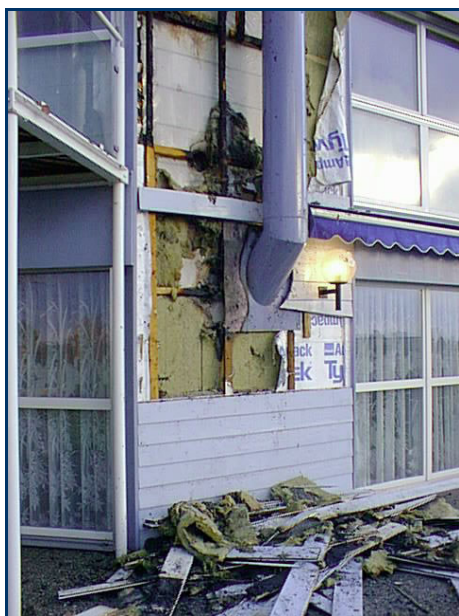
Fig. 2-21 Façade partiellement démontée par les pompiers
