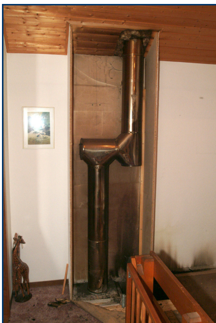
Fig. 3-10 Vue générale du conduit et du double coude non conforme
