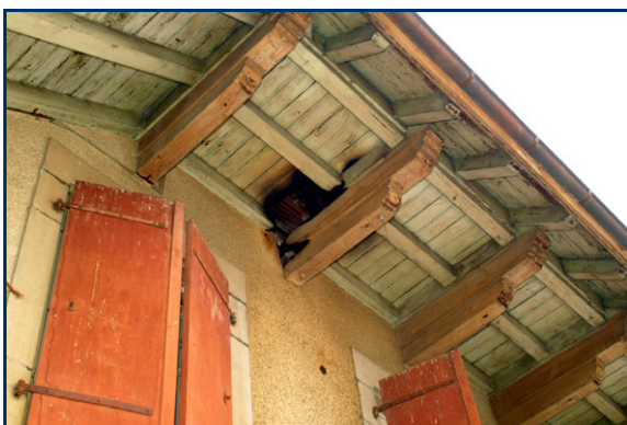
Fig. 4-28 Vue l'avant-toit et des dégâts causés sur la poutre qui passait à l'intérieur du conduit de cheminée.
